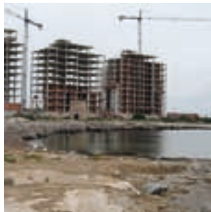
Construcción en primera línea de costa en La Manga, Murcia. © Greenpeace.
