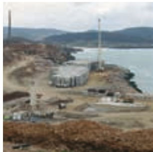
Obras en el puerto de A Coruña. © Greenpeace.
