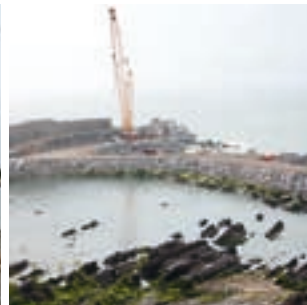
Obras en el puerto de Mutriku, Guipuzkoa. © Greenpeace.
