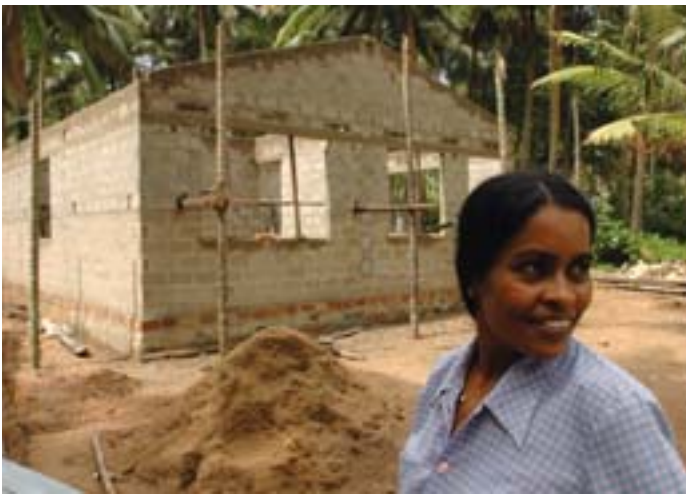
El Banco está contribuyendo a la reconstrucción de las comunidades después del devastador tsunami de diciembre de 2004.
