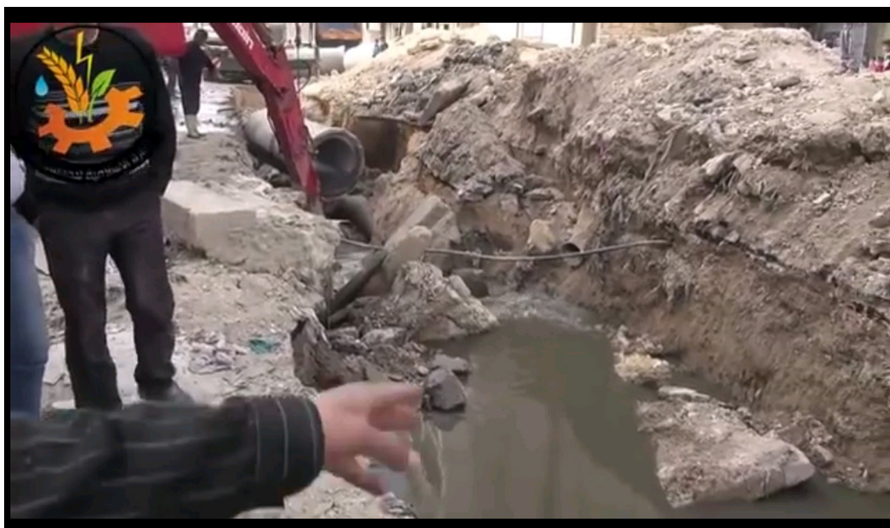
Imagen 32. Un video de Dā'ish mostrando las obras que se realizan en al-Şālahīn, un barrio en el este de Ḥalab, para refaccionar las tuberías del alcantarillado, según se indica en el título: تبدیل أنابيب الصرف الصحي الرئيسية في حي الصالحين . En el logo del video aparece la leyenda الإدارة الإسلامية للخدمات عامة , “Administración Islámica de Servicios Públicos”
