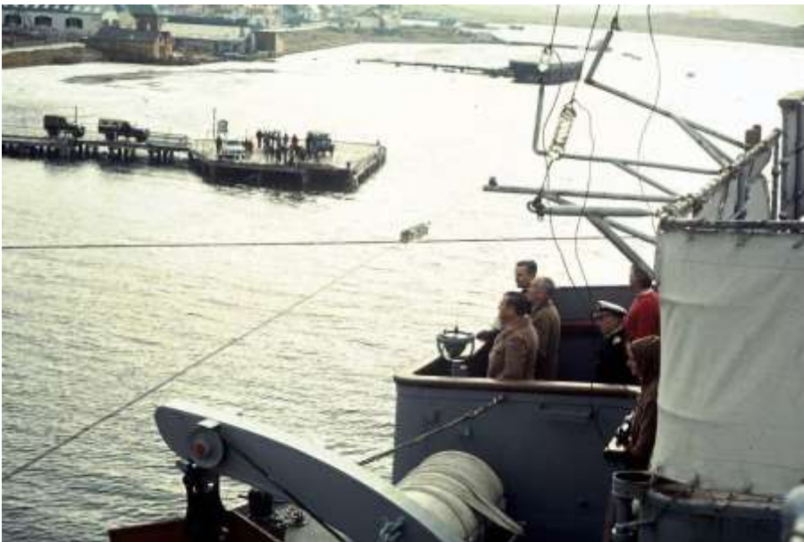
CAMPOS A BORDO DEL ARA BAHÍA BUEN SUCESO DURANTE LA INSTALACIÓN DE LA PLANTA ANTARES EN PUERTO ARGENTINO.
