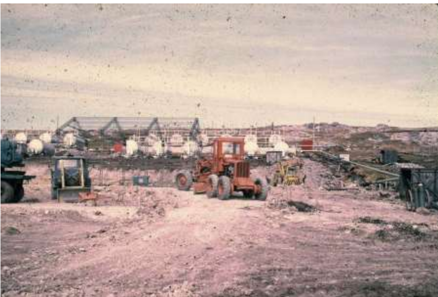
PROCESO DE CONSTRUCCIÓN DE LA PLANTA ANTARES EN PUERTO STANLEY, DONDE SE VISUALIZAN LOS TANQUES DE COMBUSTIBLES POSICIONADOS SOBRE EL TERRENO
