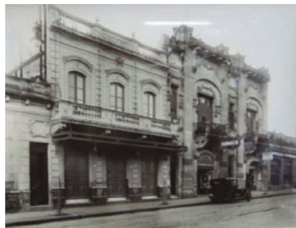
Antigua sede de calle 12 de "Unione Operai Italiani" donde se ve el gran salón de fiestas con triple entrada, luego la farmacia y la sede administrativa de la organización y en la esquina la zapatería "La Moderna". Las tres construcciones fueron demolidas.
