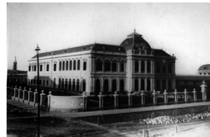
Banco Hipotecario (actual sede de la UNLP), obra dirigida por los arquitectos Buschiazzo y Veglione.
